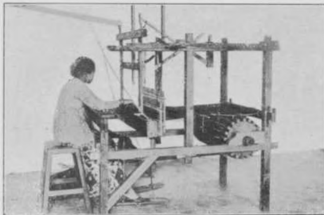
46. Europeesch weefgetouw onder de bevolking verspreid door het N.-I. Gouvernement. — European Loom distributed amongst the Natives by the Netherlands Indian Government. — Métier à tisser européen répandu parmi les Indonésiens par le Gouvernement des Indes Néerlandaises. — Europäischer Webstuhl verbreitet zwischen der Bevölkerung durch die Niederländisch-Indische Regierung.
